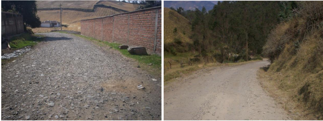
Condición de la vía de Ingreso a la Parroquia Julio Moreno
