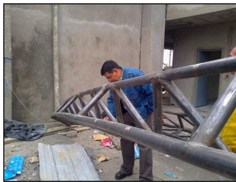
Imagen 7. Verificación de la soldadura
