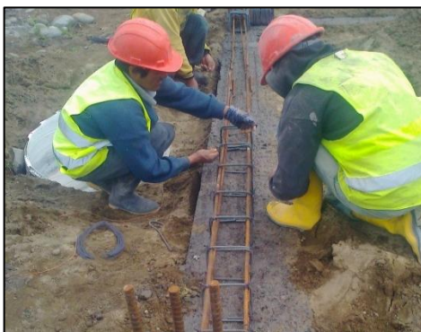
Imagen 4. Equipos de seguridad mínimos
