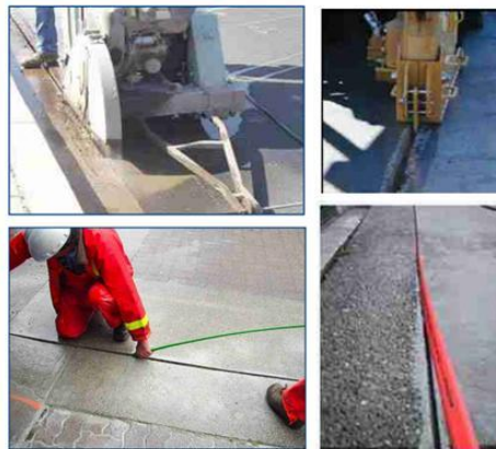
Figura 6.25: Zanjado
