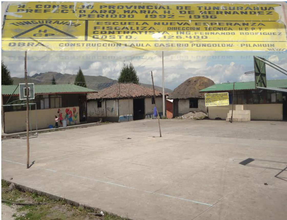
Establecimiento Educativo “NUEVA ESPERANZA”. La infra estructura
