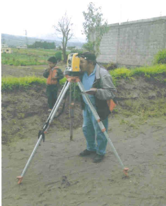
Calle los Llanganates (medición con la estación total)
