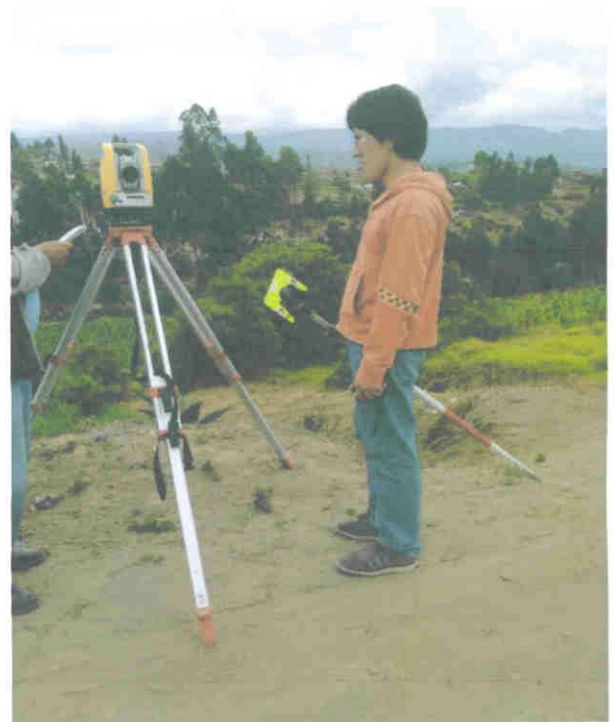
Calle los Llanganates (toma de datos de la estación total)
