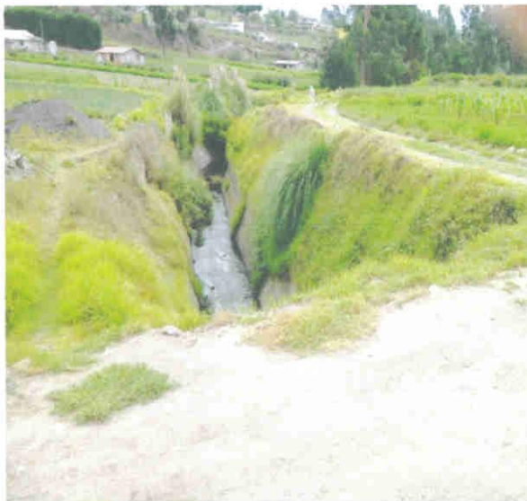
Canal de riego que atraviesa la calle los Llanganates
