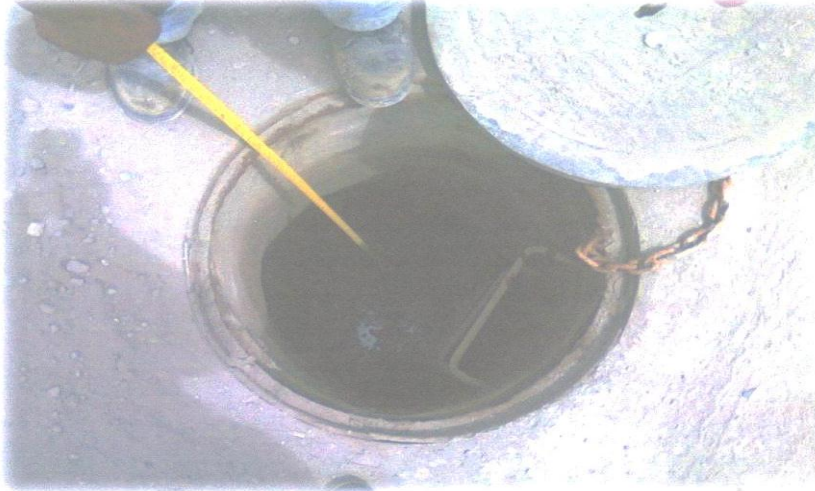
PROFUNDIDAD DEL POZO =2.30m
