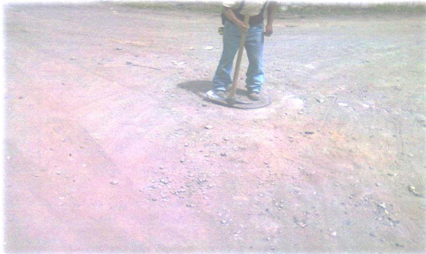
POZO DE ALCANTARILLADO
