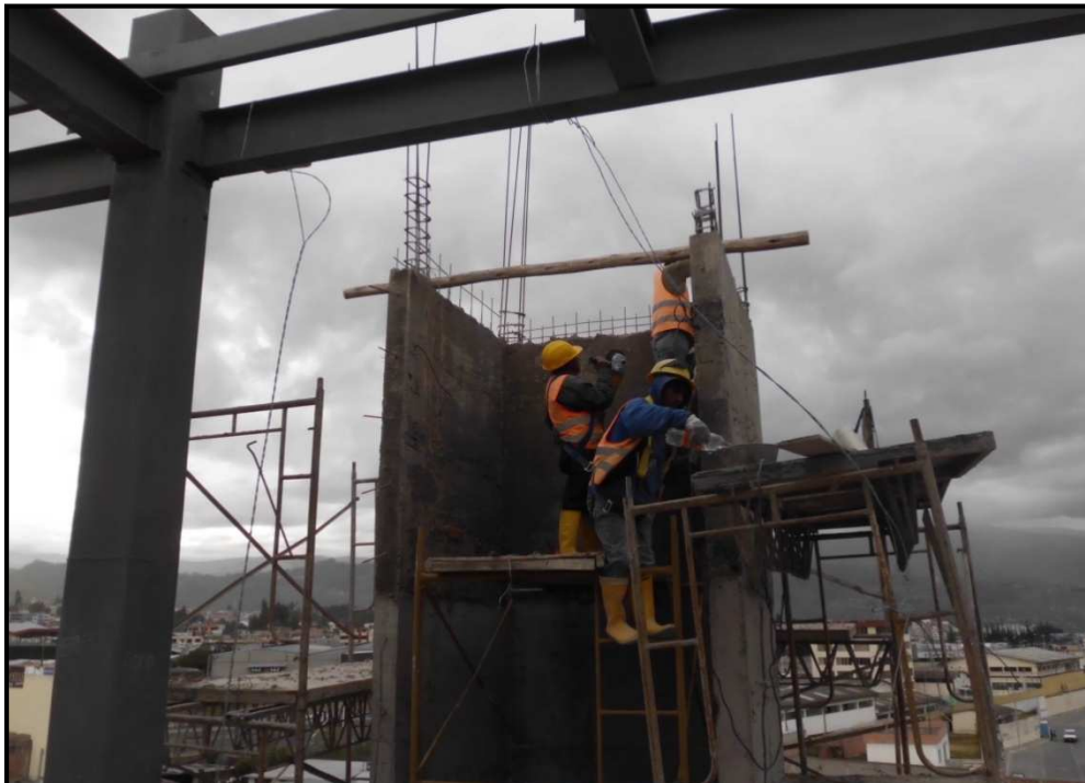
Fig. N° 22: Andamios para trabajos en ducto de ascensor
