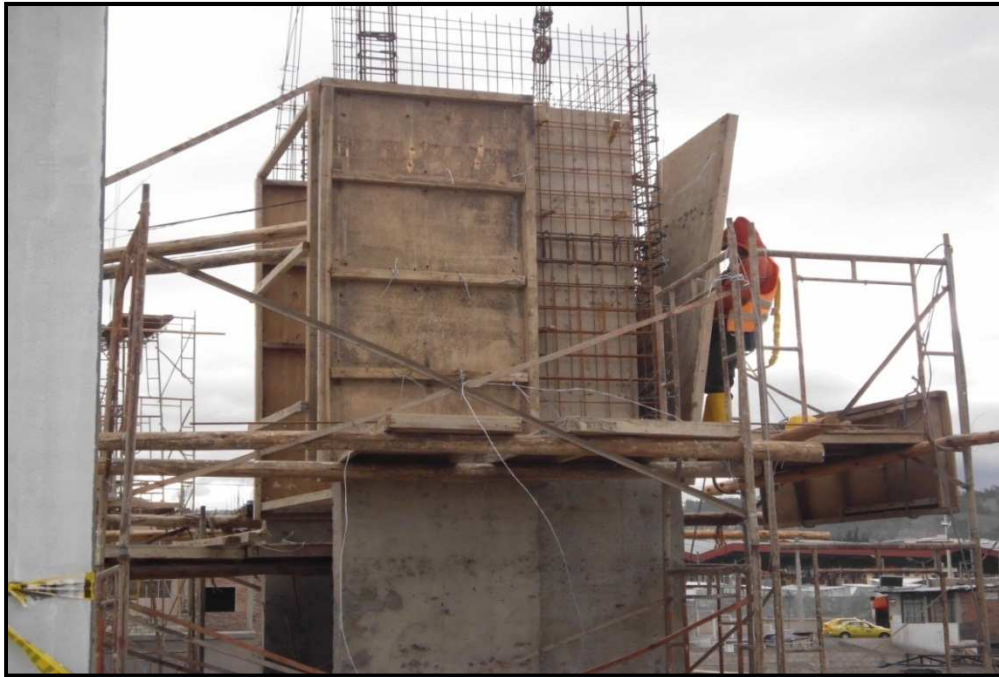
Fig. N° 20: Utilización de andamios para encofrar
