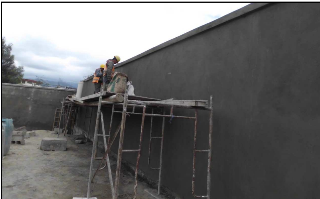
Fig. N° 26: Enlucido de mampostería con andamios
