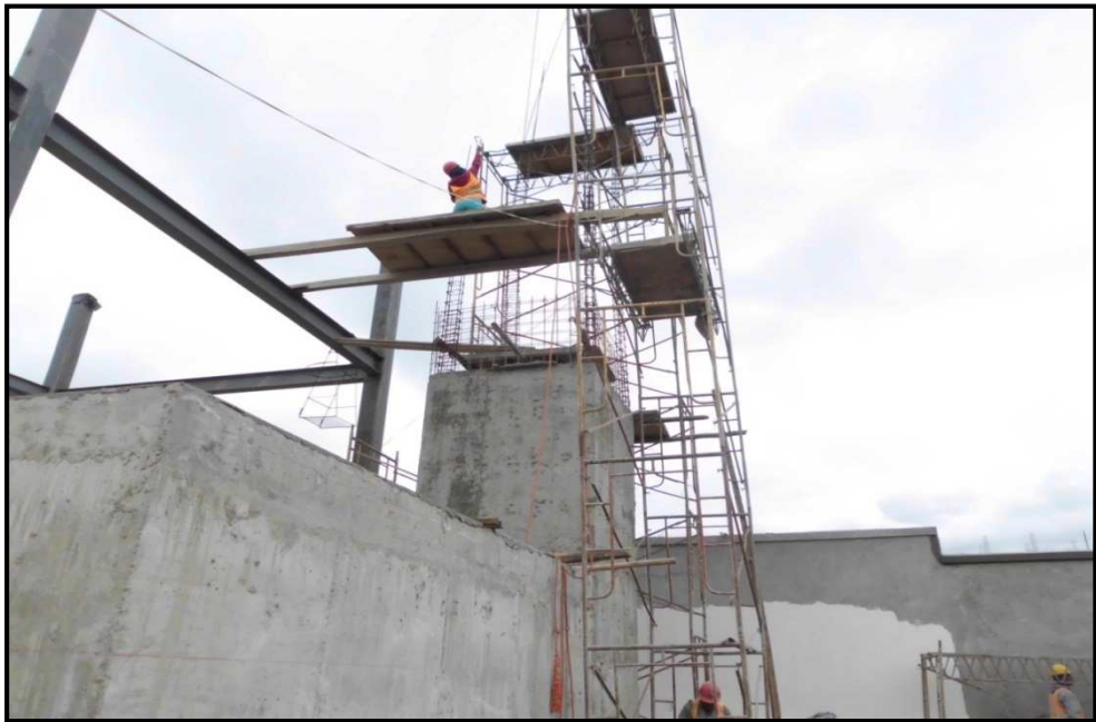
Fig. N° 18: Utilización de andamios para colocar el acero de refuerzo
