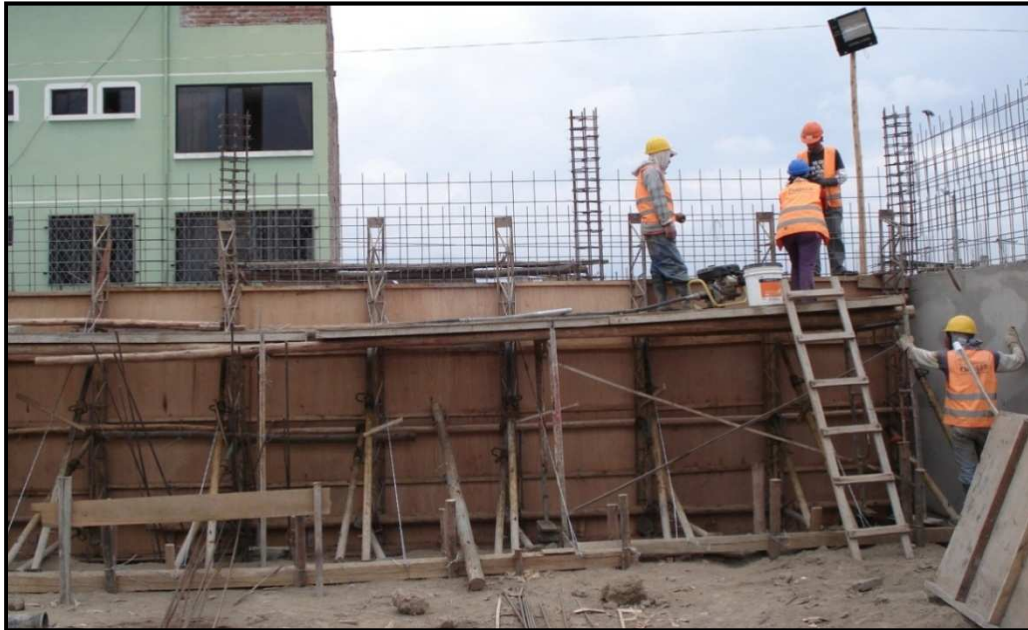
Fig. N° 05: Uso de andamios para encofrar muros
