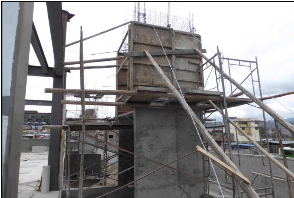
Fig. N° 20: Utilización de andamios para encofrar
