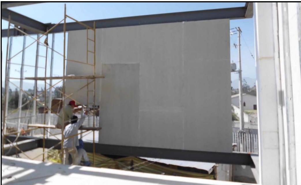
Fig. N° 12: Colocación de paredes de gypsum con andamios.
