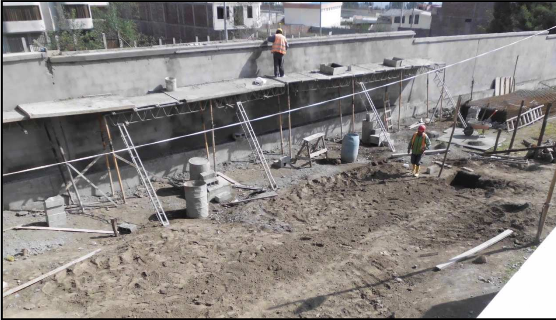
Fig. N° 27: Enlucido de mampostería con andamios
