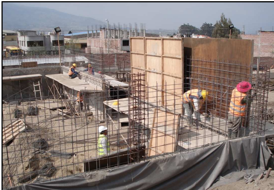
Fig. N° 06: Encofrado de muros
