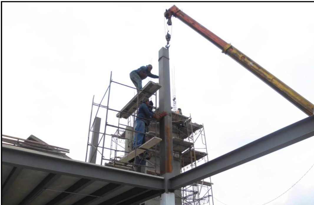
Fig. N° 10: Montaje de estructura metálica
