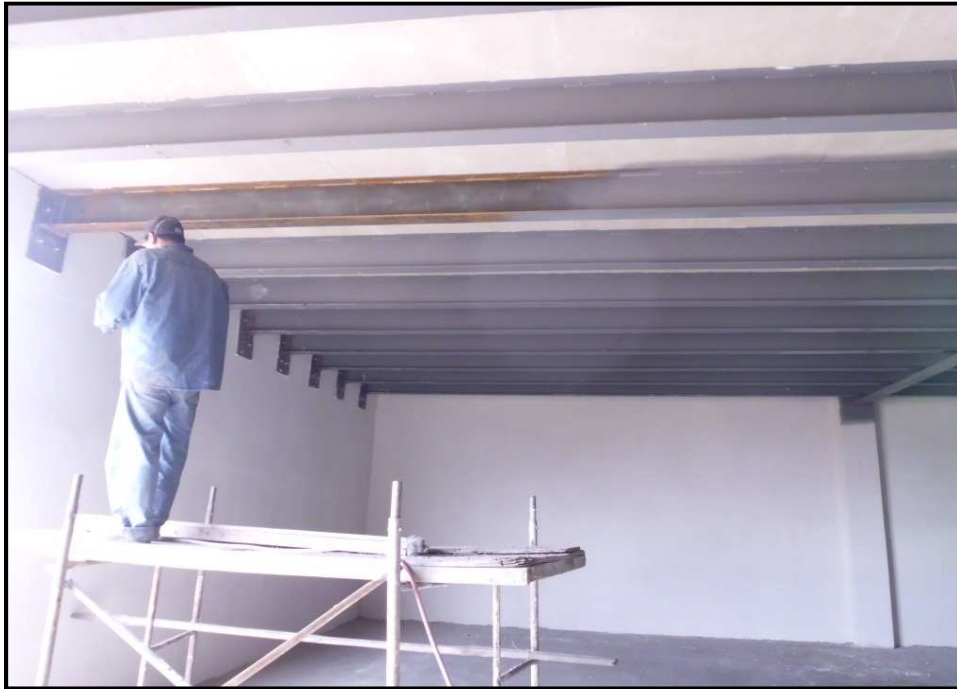
Fig. N° 14: Pintura en estructura metálica con andamios.
