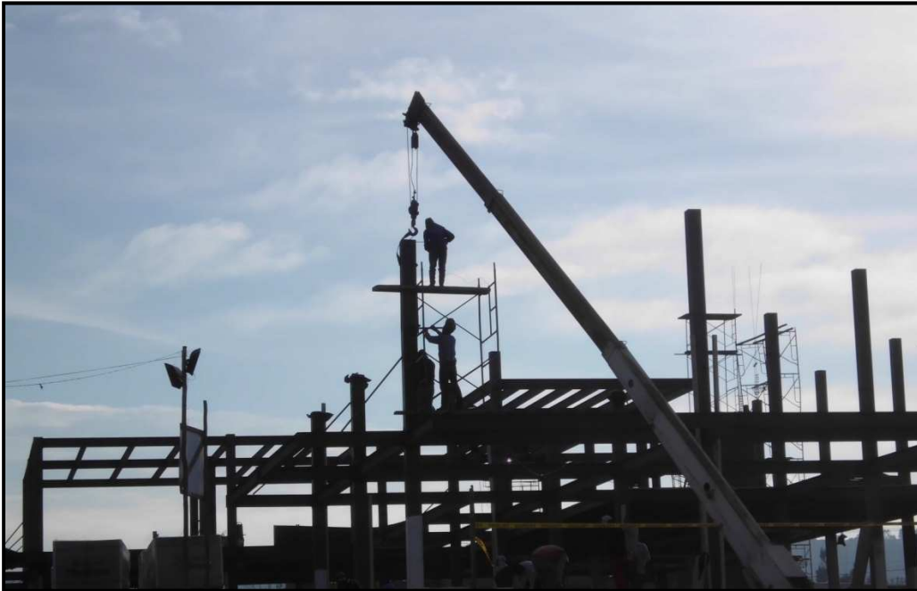
Fig. N° 11: Montaje de estructura metálica
