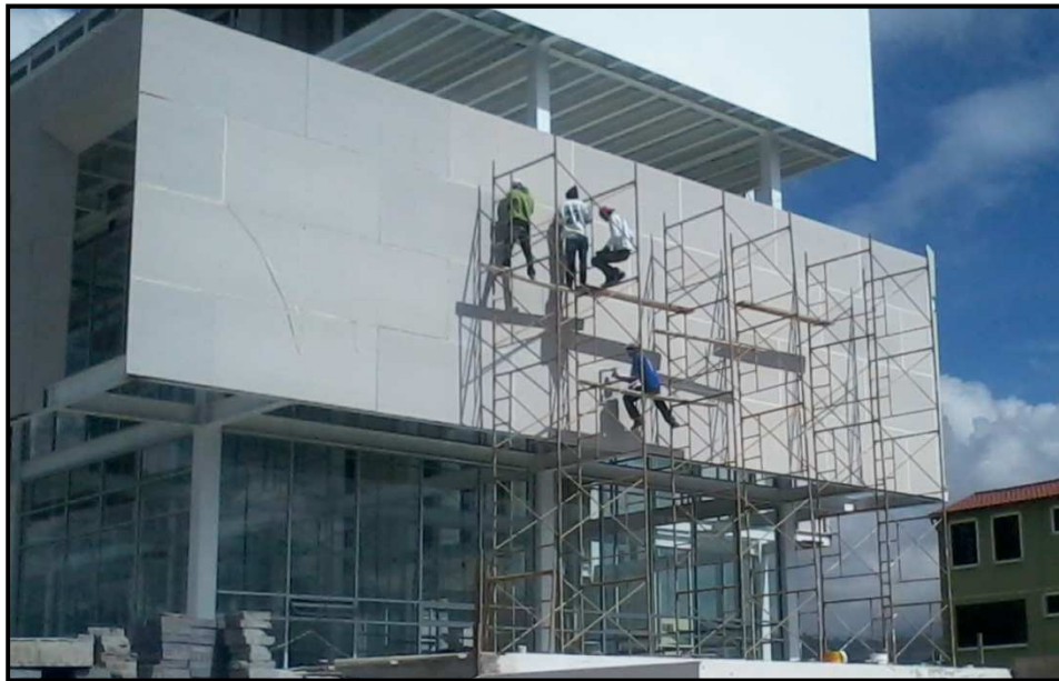
Fig. N° 16: Uso de andamios para pintura en fachadas
