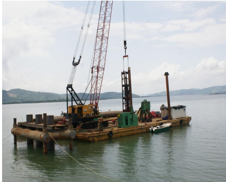
Figura N°55. Barcaza de Hinca.
