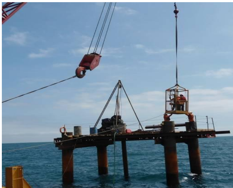
Figura N°22. Perforación P6, sobre Plataforma Costa Afuera
