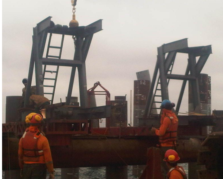
Figura N° 62. Montaje de Transformers.
