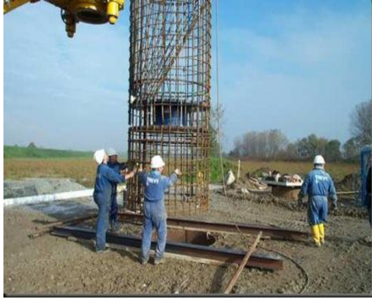
Figura N°9. Pilotes vaciados in situ.
