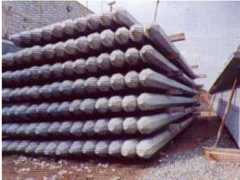
Figura N°7. Pilotes Prefabricados.
