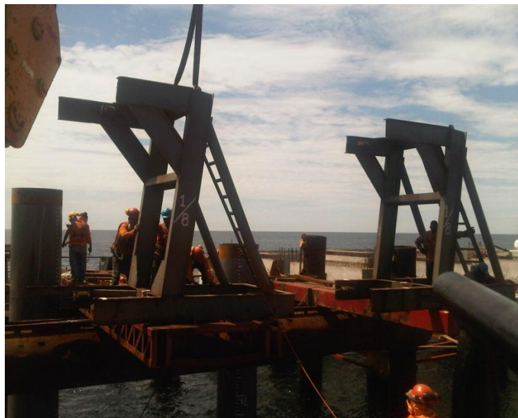
Figura N° 61. Montaje de Transformers.
