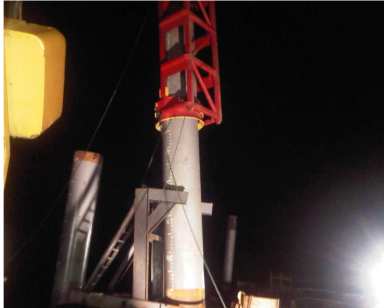
Figura N°63. Martillo Hincando un pilote.
