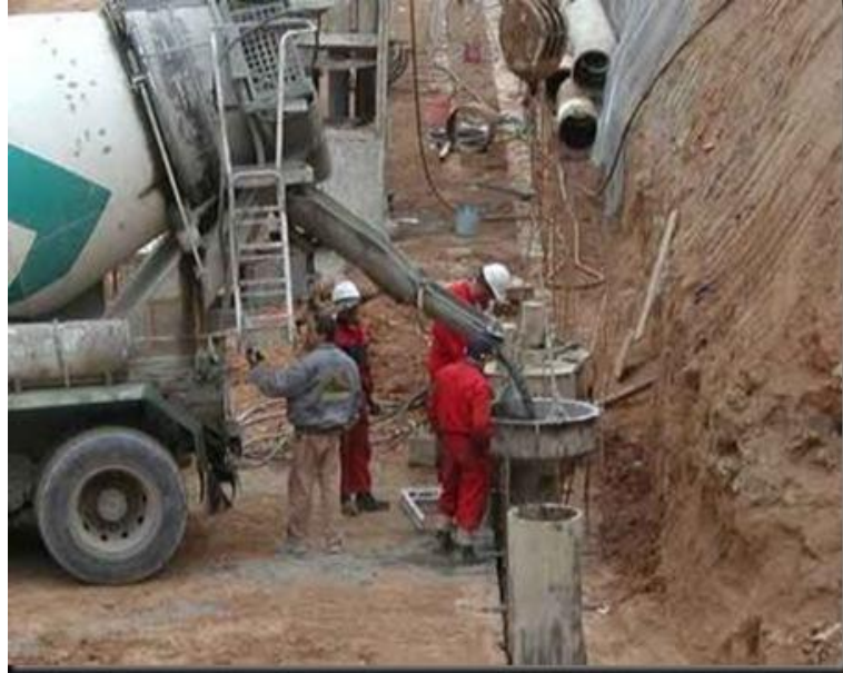
Figura N°10. Vaciado de Pilotes.
