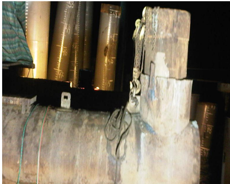
Figura N°59. Obra falsa Armada.
