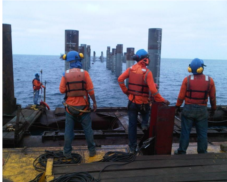
Figura N°57. Instalación de Obra Falsa.
