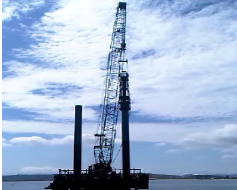
Figura N°64. Martillo Hincando un pilote.
