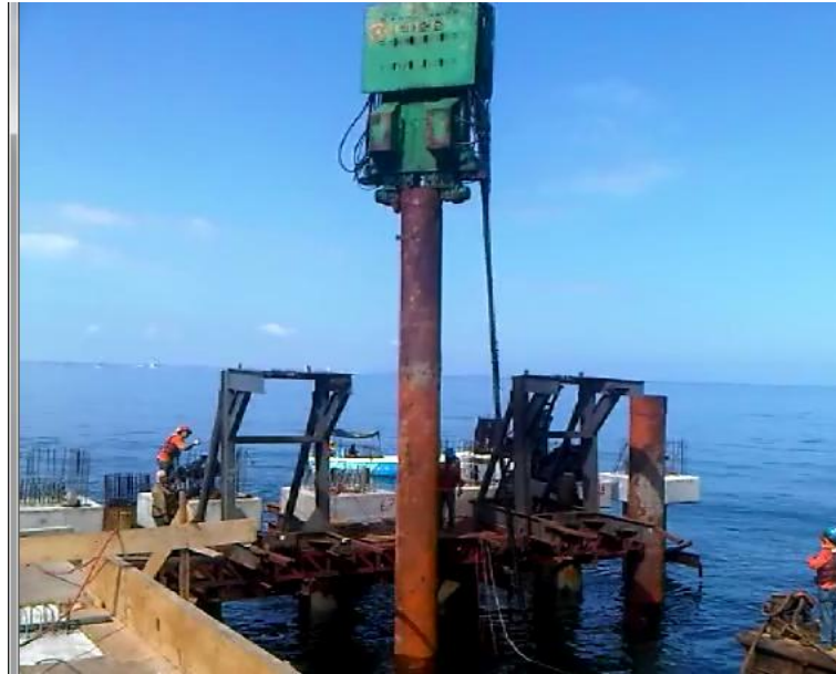
Figura N°58. Martillo Vibrando Pilote.
