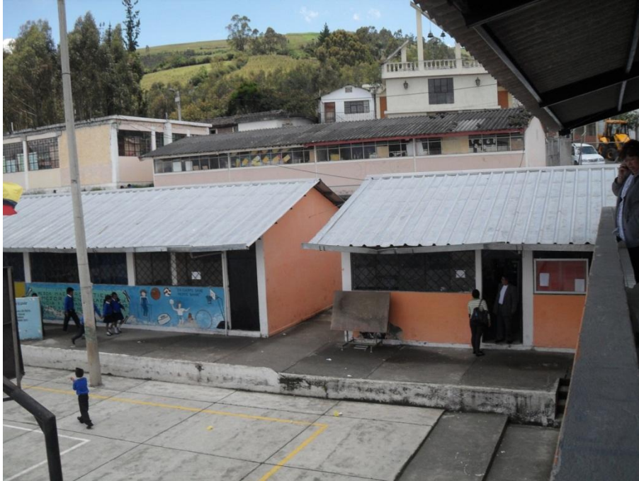
Instalaciones de la Unidad Educativa "Ingapirca"
