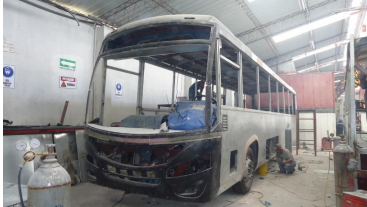
Figura 2. 14 Forrado de la carrocería
