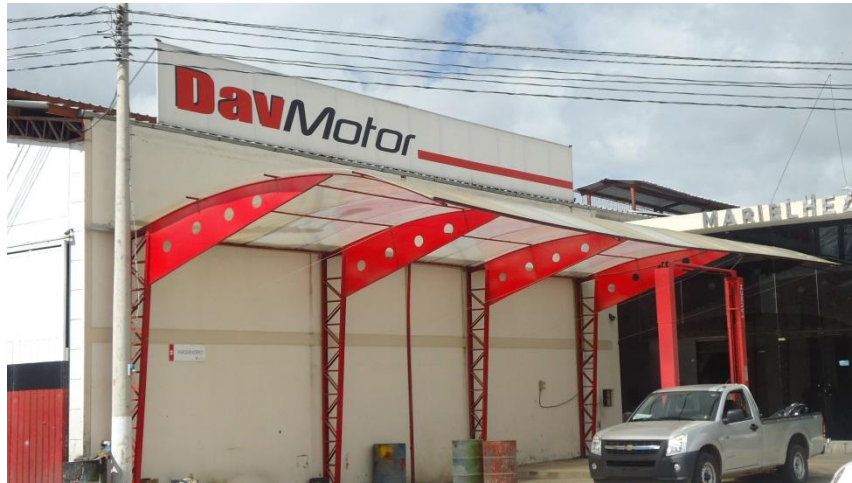
Figura 6. 19 Entrada a la planta de la empresa Davmotor Cía. Ltda.
