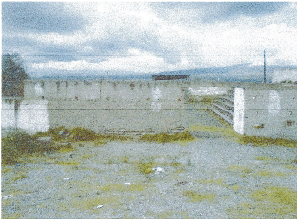
Terreno disponible para la construcción del graderío
