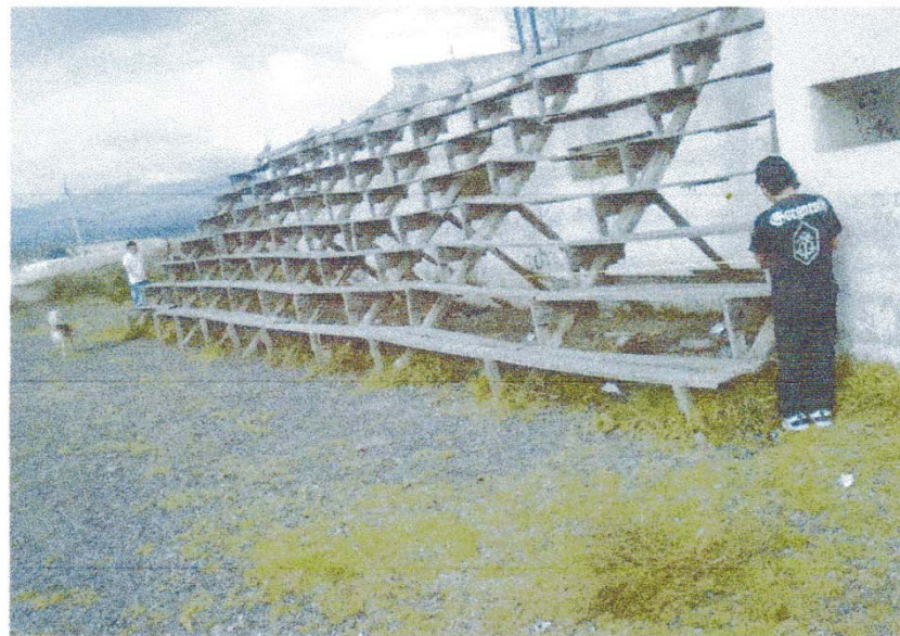
Estructura existente en el sitio.
