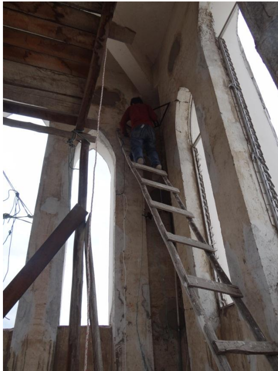
Colocación de la repisa con poleas.- etapa III
