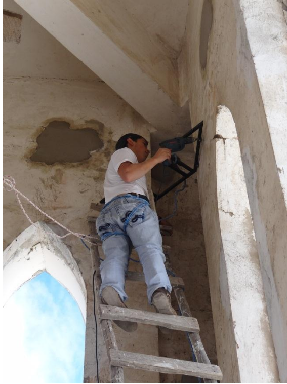
Colocación de la repisa con poleas.- etapa II
