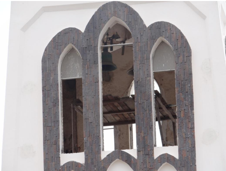
“CAMPANARIO EN RECONSTRUCCION”
