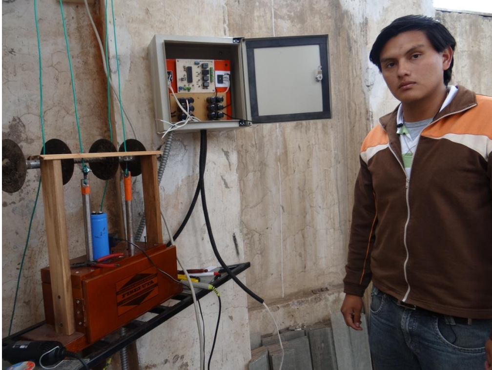
Resultado final del sistema de control
