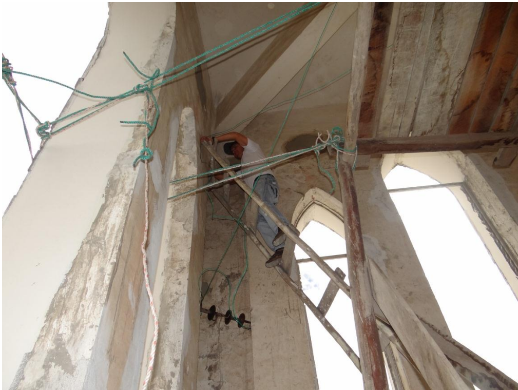
Colocación de la repisa con poleas.- etapa I
