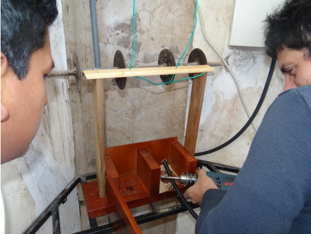
Trabajos con la caja contenedora: parte III
