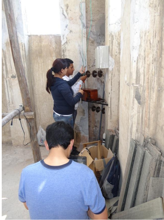
Trabajos con la caja contenedora: parte I
