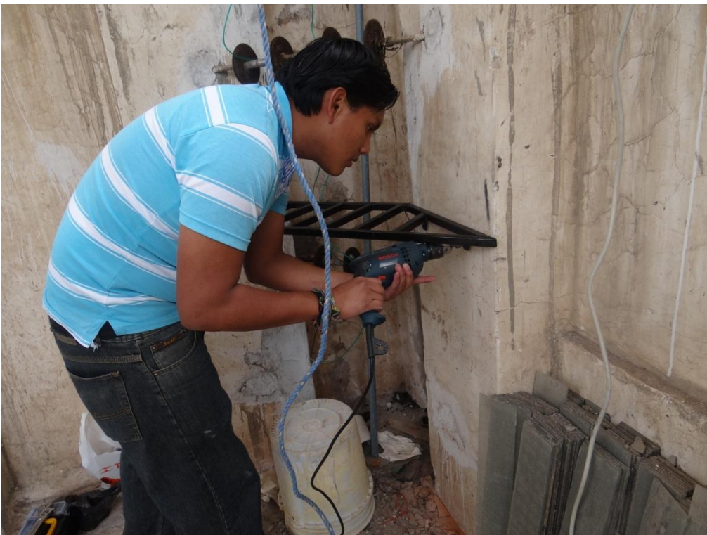
Instalación de la repisa para los electroimanes
