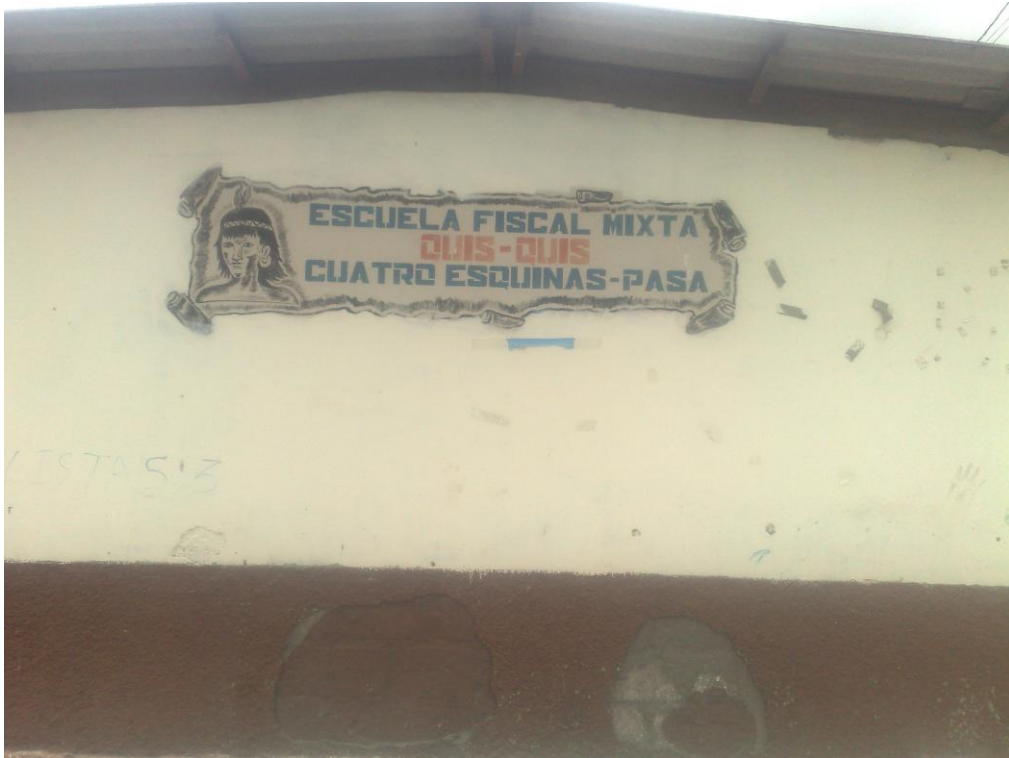
FACHADA DE LA INSTITUCIÓN
