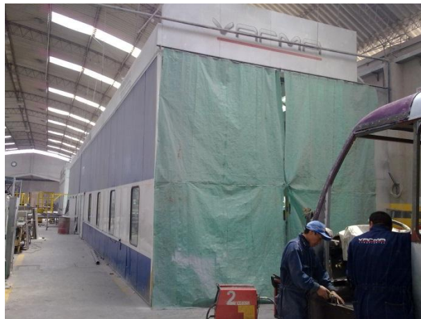
Foto N. 10: Área de Pintado de Estructura Armada
