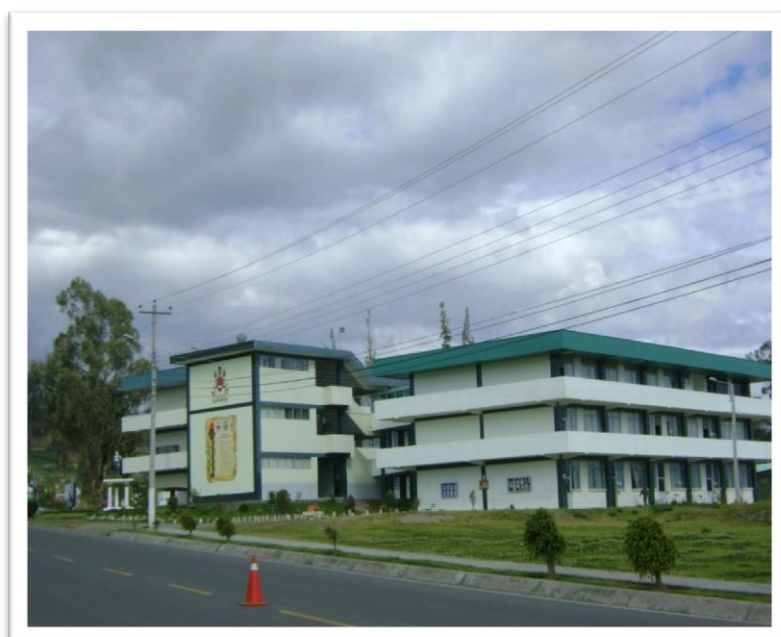
Bloque de aulas
