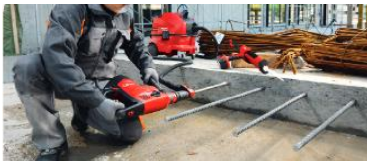
Ilustración 2. Pernos de anclaje en concreto [30]
