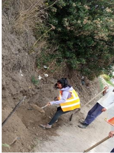
Figura 7 Realización de calicata
