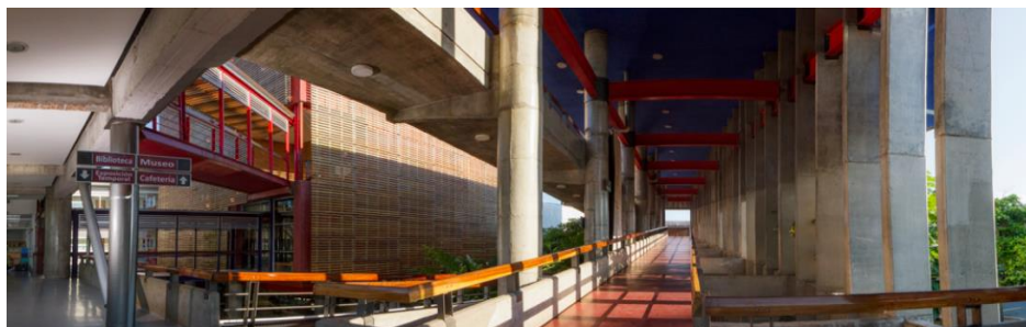
Figura 55. Ingreso al edificio arqueológico
