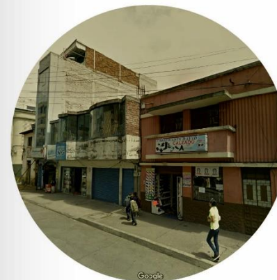
Conjuntos Arquitectónicos en condiciones de deterioro y/o subutilización
