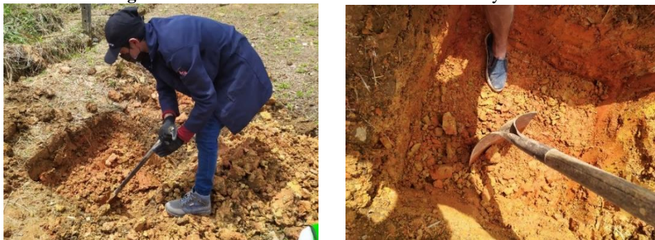
Imagen N° 01. Excavación de una calicata cantón Puyo
