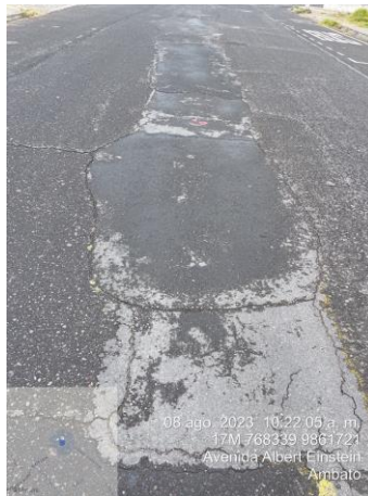
Ilustración N° 19 Parcheo Zona 35 Techo Propio – Tiuhua (Ambato, Tungurahua)
