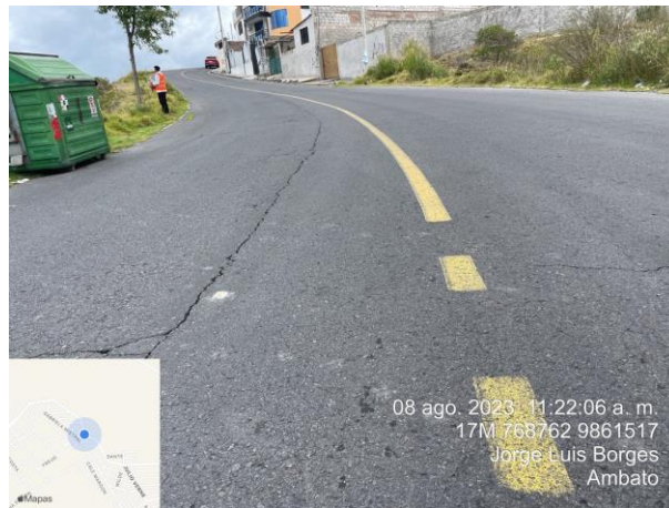
Ilustración N° 16 Grietas Longitudinales o Transversales Zona 35 Techo Propio – Tiuhua (Ambato, Tungurahua)
