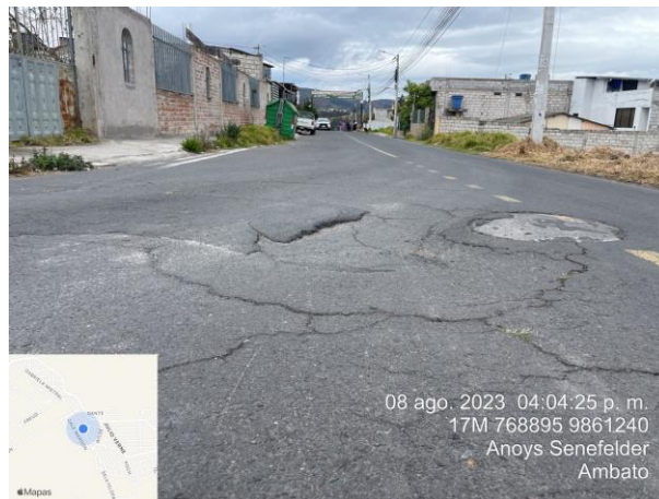
Ilustración N° 10 Depresión Zona 35 Techo Propio – Tiuhua (Ambato, Tungurahua)
