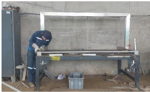
Figura 20. Etapa de ensamble y conformado
