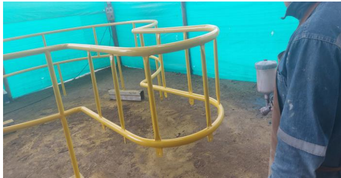
Figura 22. Etapa de pintura y acabados
