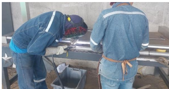
Figura 21. Etapa de soldadura
