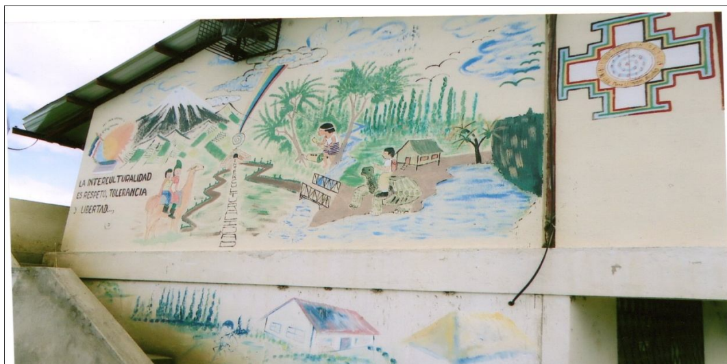
Parte de la infraestructura del Centro Educativo
