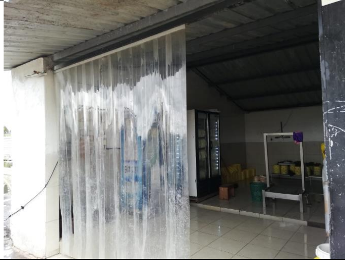
La entrada principal se encuentra cubierta por cortinas de PVC.
