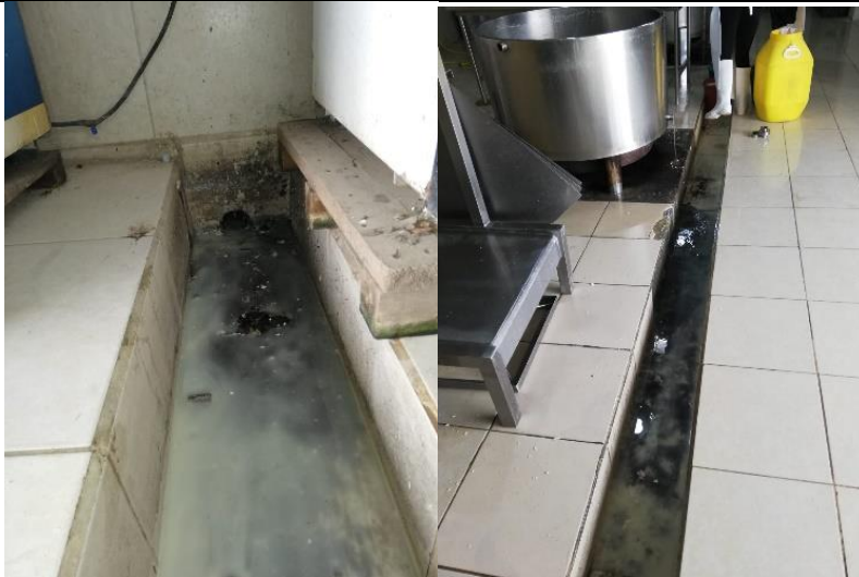
El sistema de drenaje y sumideros no se encuentran cubiertos con rejillas de sifón, y no cuenta con rejillas de drenaje.
