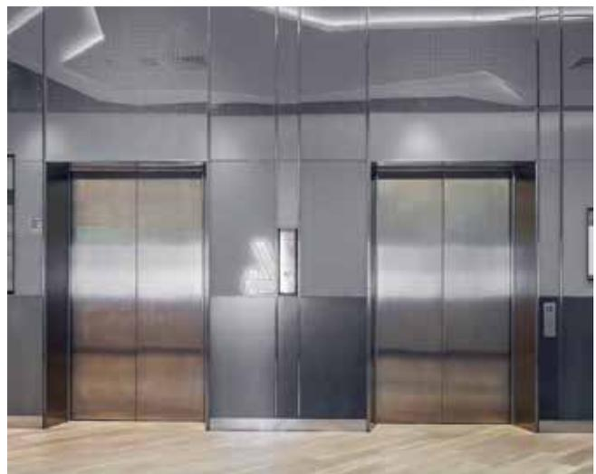
Descripción: Acero inoxidable aleado al cromo y níquel, muy resistente a la corrosión intergranular y a los ataques químicos del medio ambiente. Posee una buena resistencia a la corrosión del agua, ácidos y soluciones alcalinas si se emplea con superficie pulida a espejo. Se la puede encontrar en acabados: 2B, N1 y N4.
