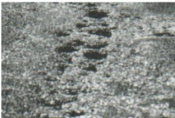
**Gráfica 22** Falla tipo Desprendimiento de Agregados
