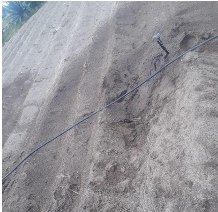
Figura 48. Dispositivos colocados en el banco de pruebas
