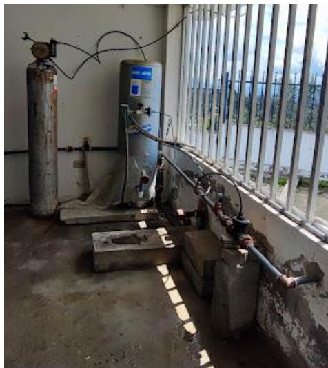
Figura 13: Zona de Desinfección.
