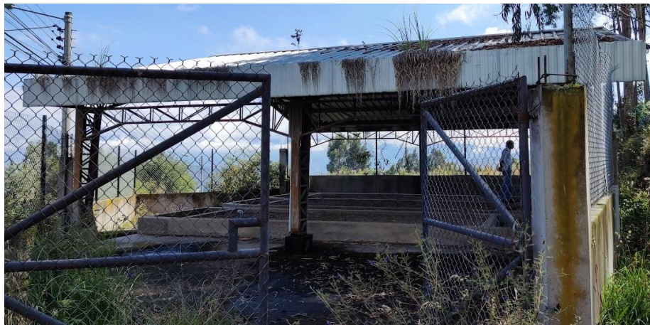
Figura 17: Zona previa PTAP “El Mirador”.
