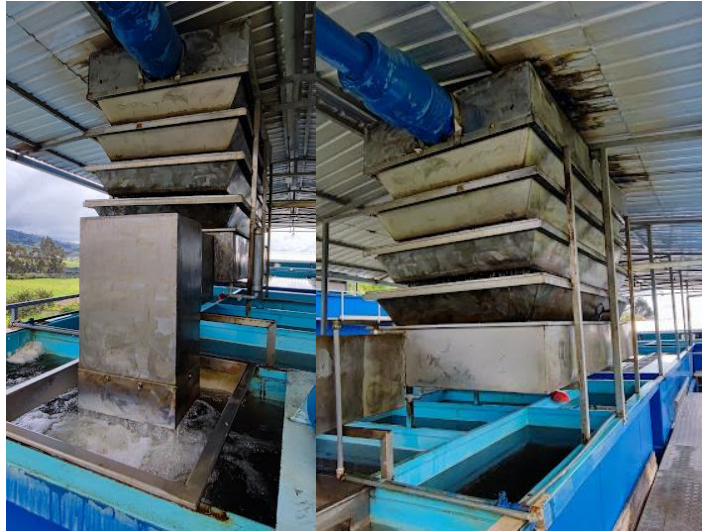
Figura 29: Torres de bandejas múltiples para la aireación del agua.
