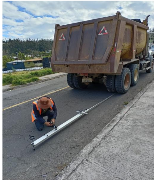
Fotografía 2. Toma de deflexiones en la capa de rodadura
