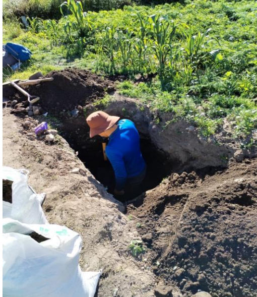
Fotografía 1. Excavación de calicatas
