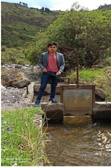
Figura 1: Medición y evaluación de la obra de captación Pucara (Inhabilitada)
