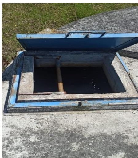
Figura 54: Toma de muestras del agua potable en los Tanques de Almacenamiento de la parroquia Presidente Urbina
