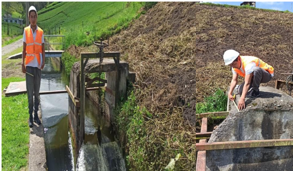
Figura 44: Zona de captación a través del canal de riego Fuente: Autor.
