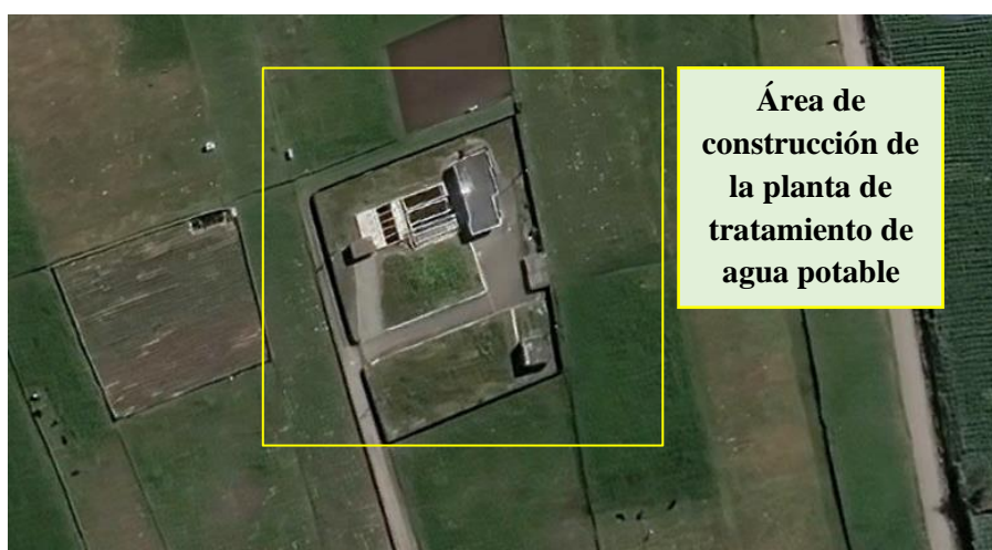
Figura 18: Planta de tratamiento de agua potable Santa Rita - Píllaro Fuente: Autor
