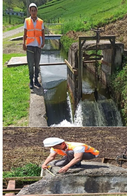
Figura 2: Levantamiento de la información en captación (Habilitada)
