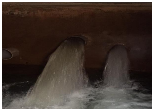
Figura 29: Entrada del caudal al tanque colector Fuente: Autor.
