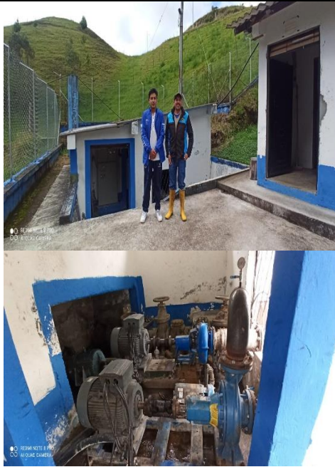
Figura 5: Levantamiento de la información en la estación de bombeo.
