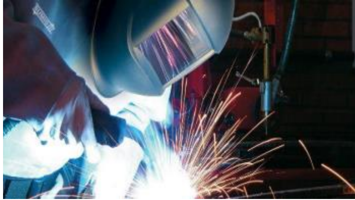
Figura 14. Soldadura de las piezas.
