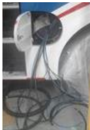
Figura 33. Colocación de tuberías neumáticas.
