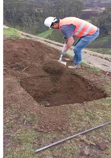
Relleno de la calicata con suelo excavado
