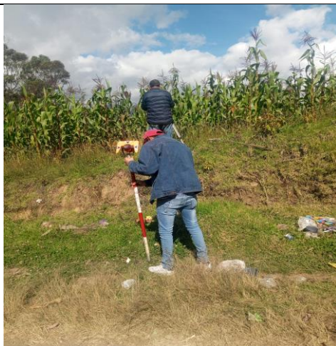
Implantación de equipo topográfico
