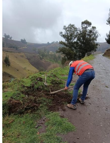
Excavación de pozo de prueba
