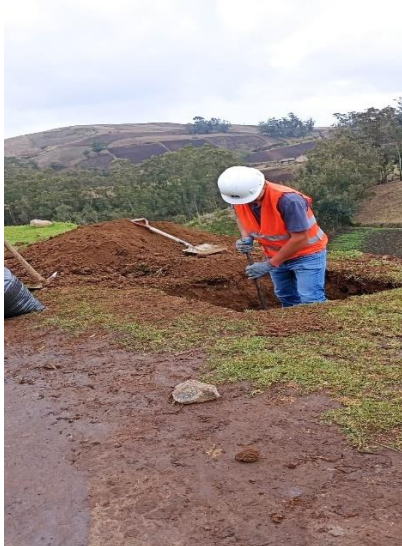
Excavación de calicata
