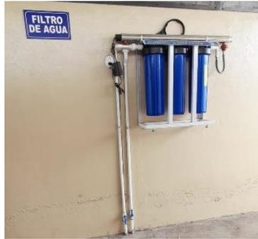
**Figura 6** Equipo de filtración y esterilización de agua
