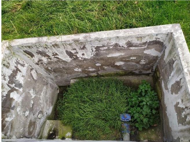
*Ilustración 27: Falta de mantenimiento en la infraestructura de la PTAR
