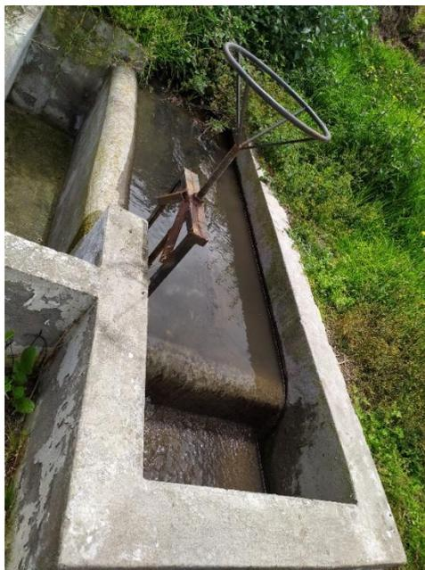
*Ilustración 17: Tanque Desarenador de la PTAR*
