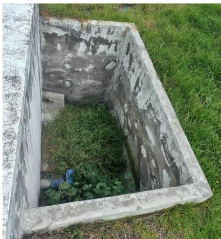
*Ilustración 21: Tanque de secado de lodos de la PTAR*
