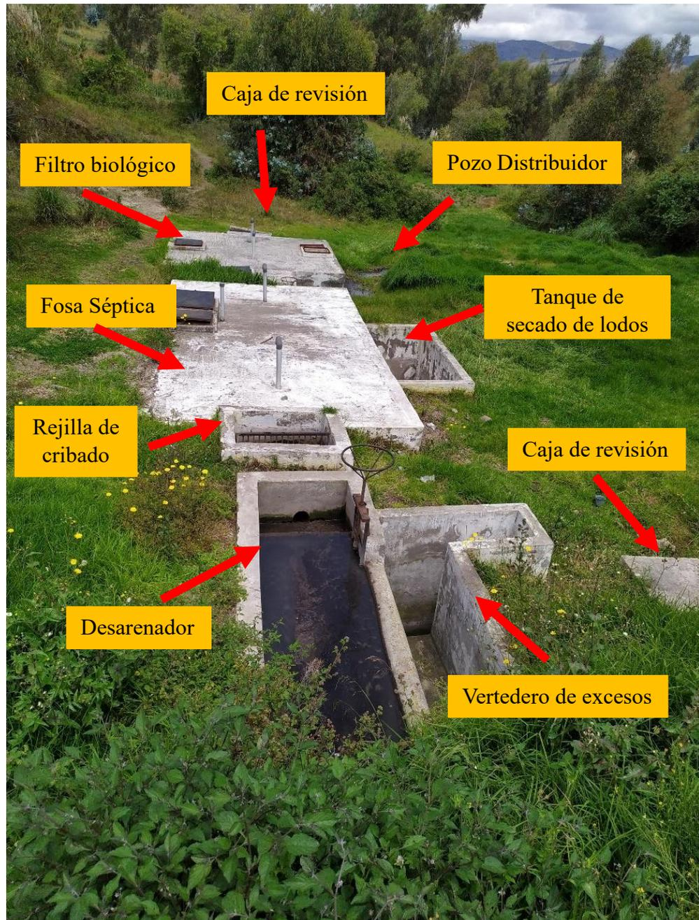
*Ilustración 7: Infraestructura externa de la PTAR Cuicuno
