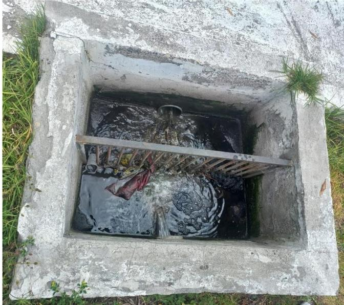
*Ilustración 19: Rejillas de cribado de la PTAR*
