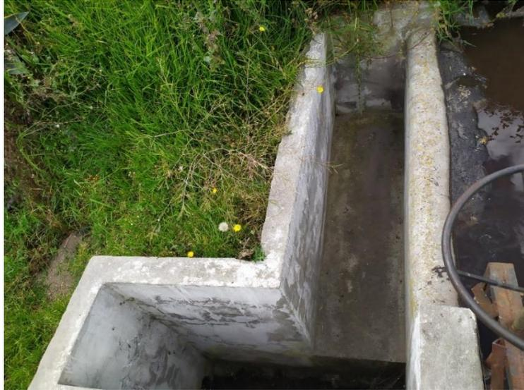
*Ilustración 18: Vertedero de excesos de la PTAR*
