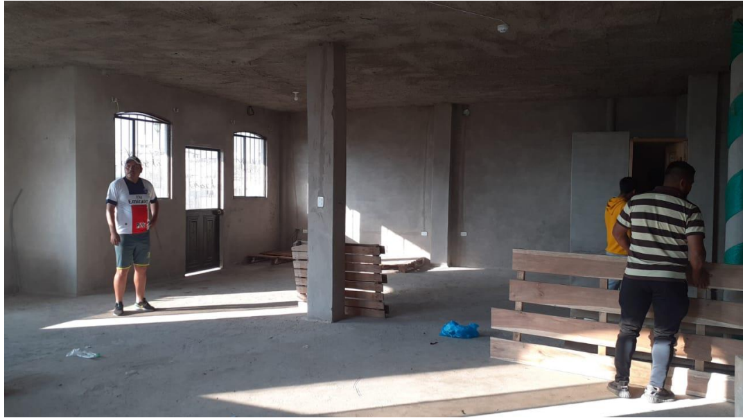
Figura 4-60. Colocación de pallets
