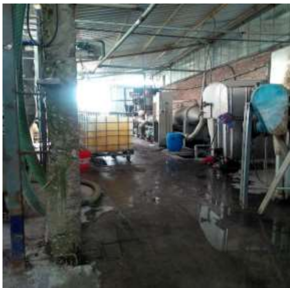
Figura 30: Presencia de agua en los pisos – muda movimientos innecesarios.
