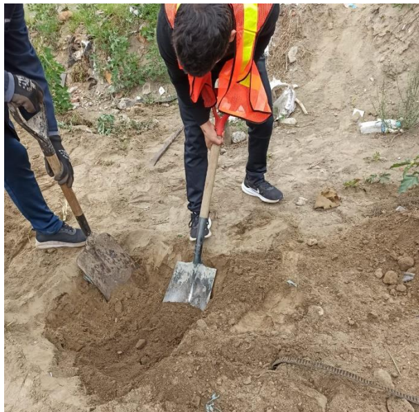
Figura 65: Excavación del pozo.
