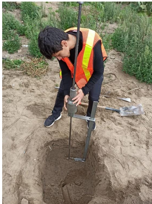
Figura 69: Aplicación de golpes para la penetración.
