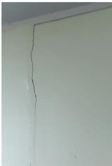
Fig. 3. 37: Fotografía de grieta en la columna F9.
