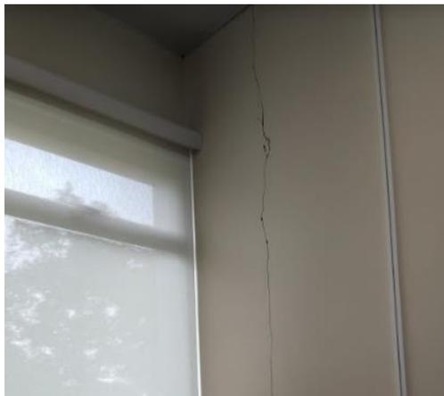
Fig. 1. 4: Fotografía de fisura en la columna del eje G9.
