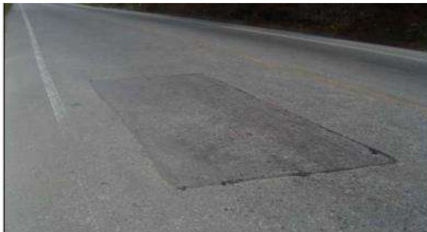
Figura N° 14: Parcheo en pavimentos flexibles
