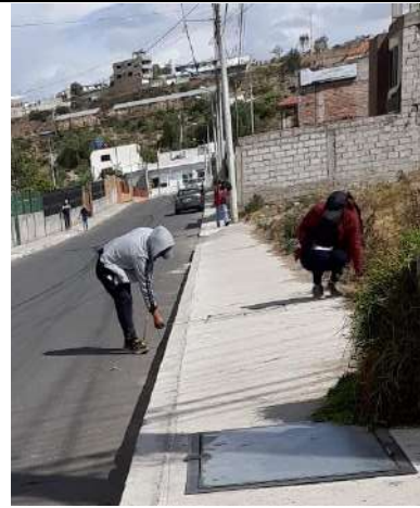
Medición de acera y bordillo
