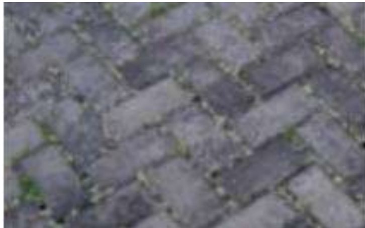
Figura N° 36: Vegetación en pavimentos articulados
