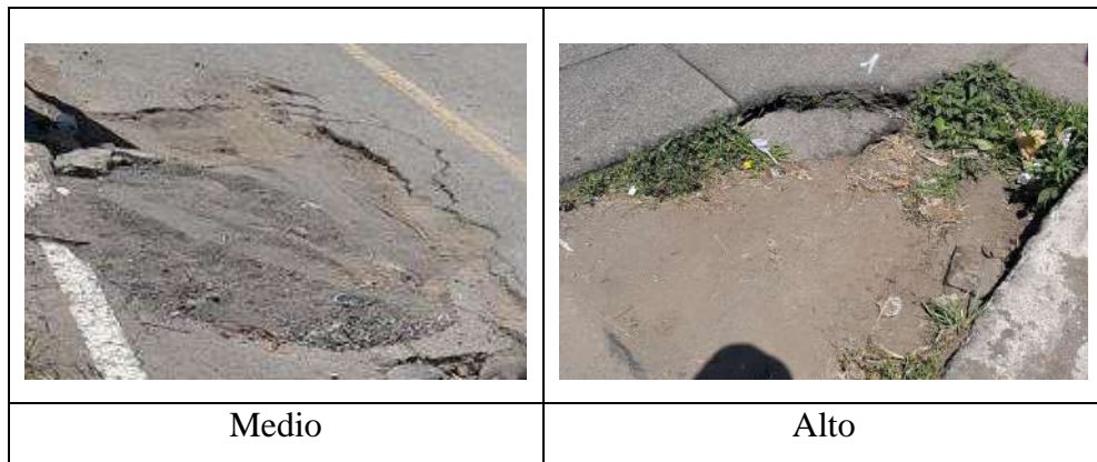
Figura N° 61: Tipos de severidades encontradas en la "Zona 28" – Huecos
