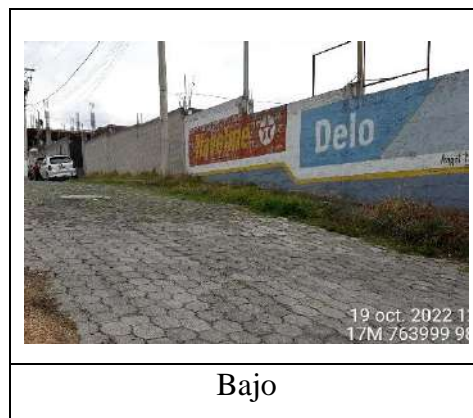
Figura N° 71: Tipos de severidades encontradas en la “Zona 28” – Vegetación en la calzada
