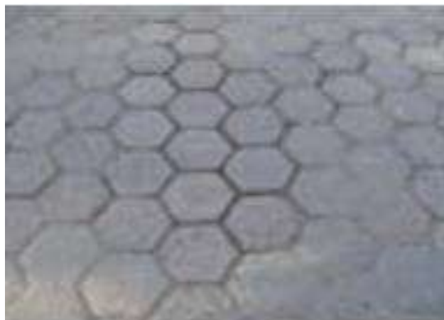
Figura N° 35: Juntas abiertas en pavimentos articulados
