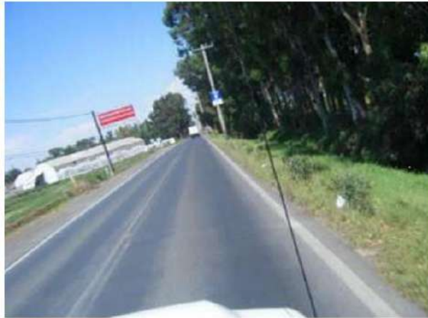
Figura N° 4: Exudación en pavimentos flexibles
