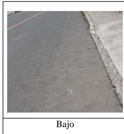
Figura N° 51: Tipos de severidades encontradas en la “Zona 28” – Corrugación
