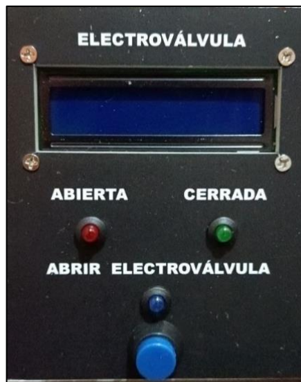
Figura 73: Estado de la electroválvula.
