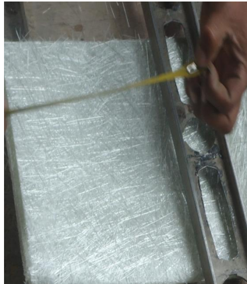
Cortamos la Fibra de Vidrio a medida del encofrado
