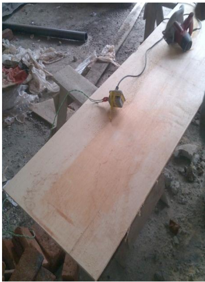
Utilizando desmoldante para que no se peguen al desencofrar
