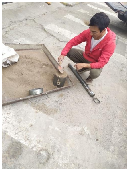
Ejecución del ensayo de compactación (Proctor Modificado)
