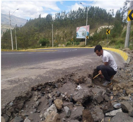
Extracción de las muestras de suelo en la vía
