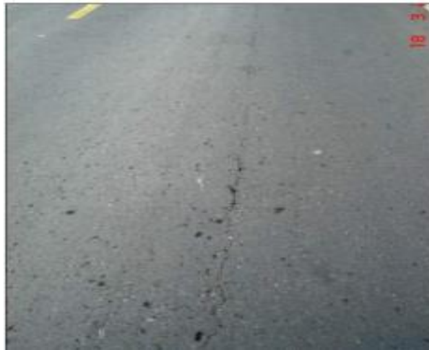
Figura 1. 6 Fisura Longitudinales [26].
