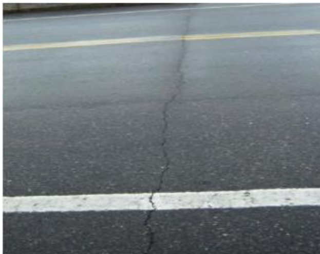
Figura 1.7 Fisuras Transversales [26].
