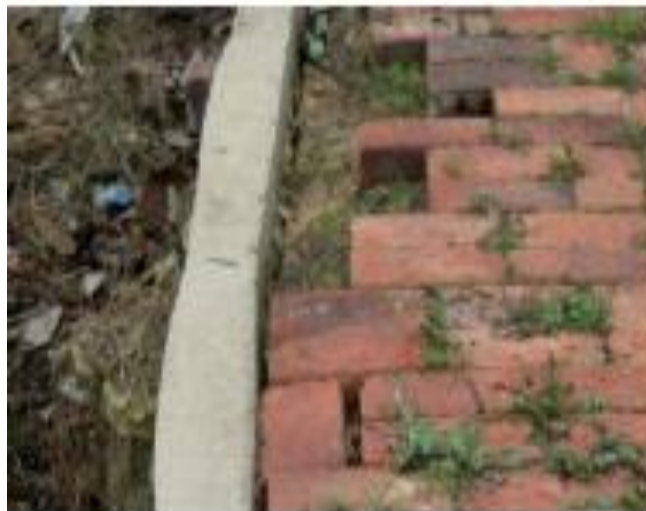
Figura 1. 36 Desplazamiento de bordes [34].
