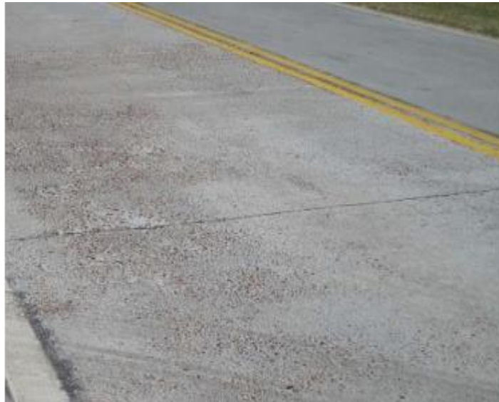
Figura 1.26: Descascaramiento [26].
