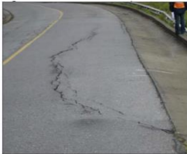
Figura 1.8 Fisuras Parabólica [27].
