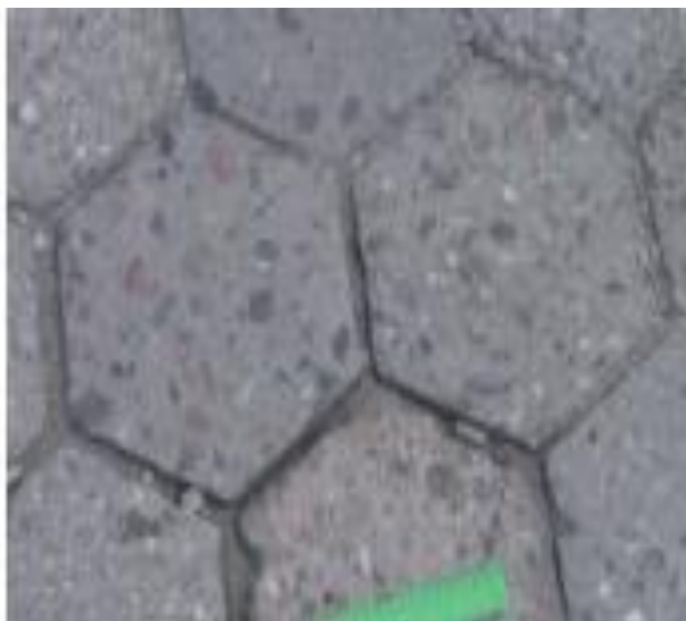
Figura 1.34 Desgaste Superficial [34].
