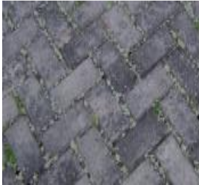
Figura 1.43 Vegetación en la calzada [34].
