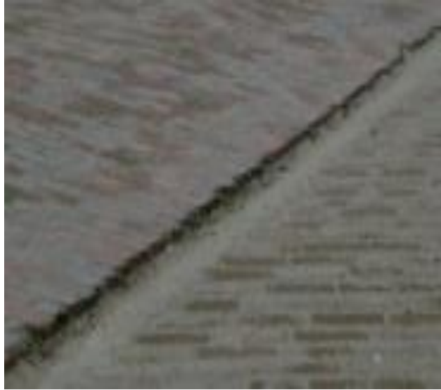
Figura 1.41 Escalonamiento entre Adoquines [34].
