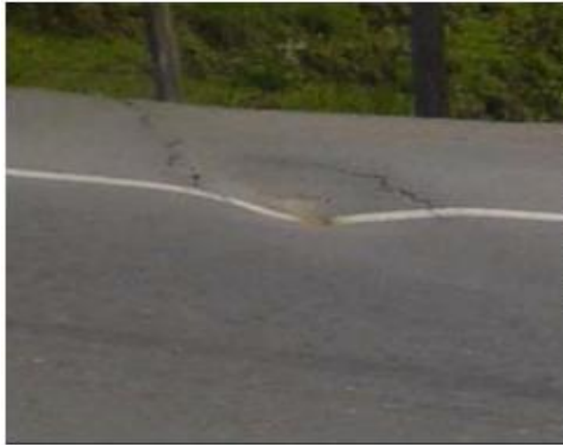
Figura 1.2 Hundimiento y Abultamiento [21].
