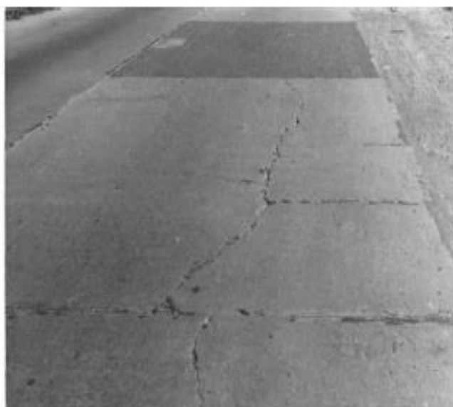
Figura 1. 24: Fisura Múltiple [24].
