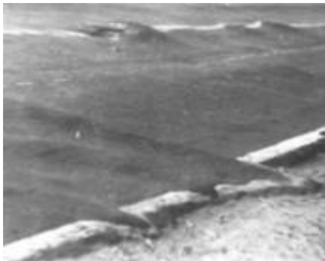
Figura 1. 4 Corrimiento de severidad alta [24].
