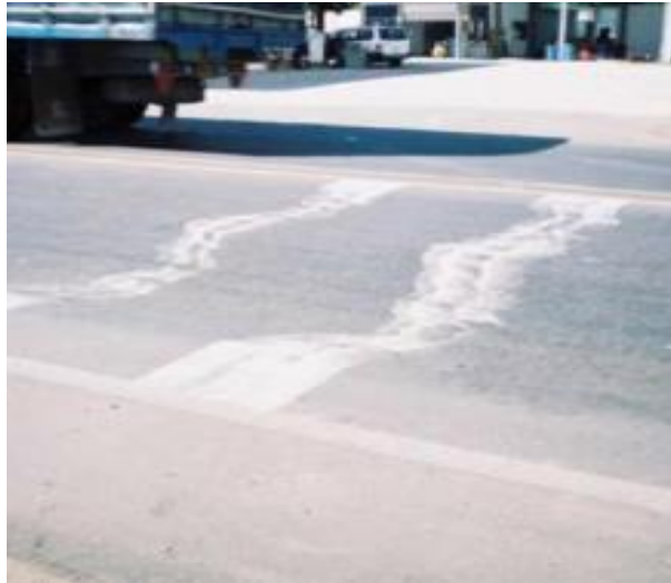
Figura 1.1 Ahuellamiento [21].
