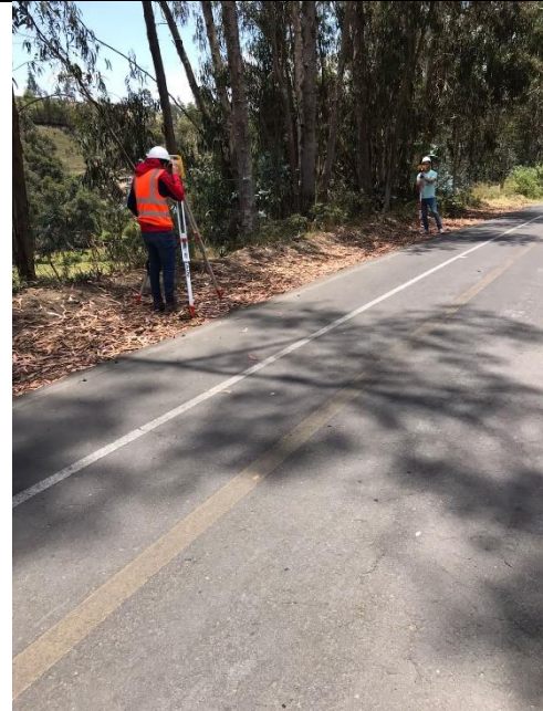
Tomando puntos en la carretera por donde irá el diseño de agua potable.
