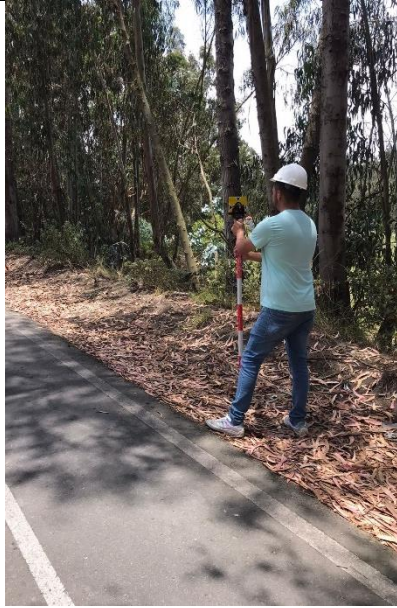
Nivelando el bastón con el prisma para la toma y anotación de puntos para el diseño de agua potable.
