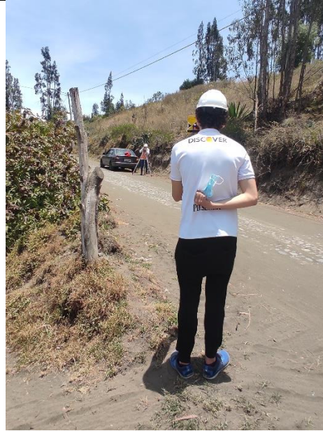
Tomando puntos para el proyecto, se tomó puntos en el eje y al borde de la vía.
