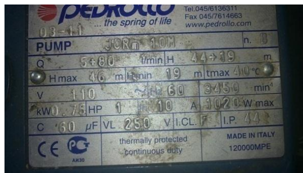
Fig. 4.3: Placa de características de la bomba del fluido caliente.
