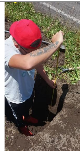
Medición de profundidad de calicata.
