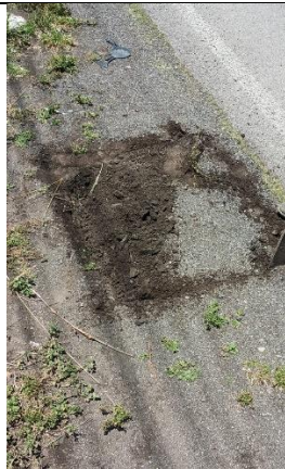
Marcando dimensiones de calicata.
