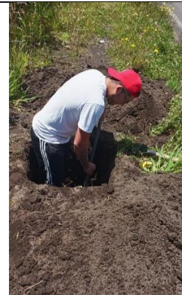
Excavación de calicata.
