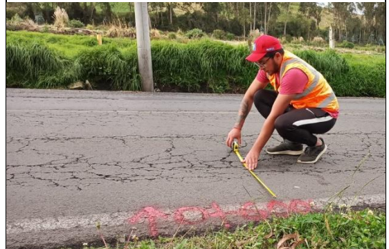
Medición para señalética del ensayo.
