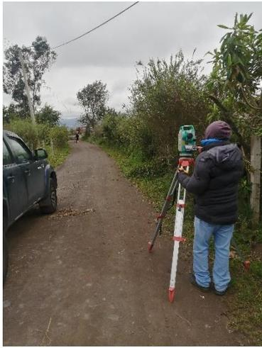
Fotografía 5: Levantamiento topográfico para sistema de alcantarillado
