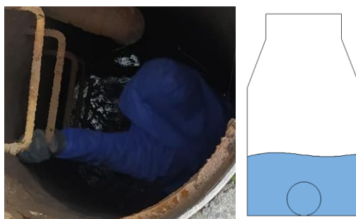
Ilustración 26.- Visualización y Esquema del Problema por Diámetro Insuficiente
