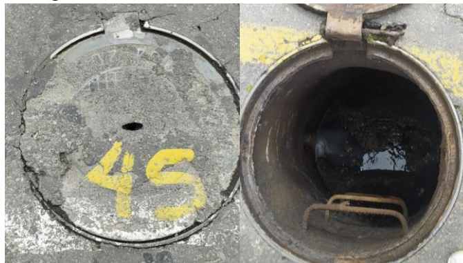
Ilustración 22.- Tapas de Pozos que Presentan Problemáticas en Anillos y Bisagras
