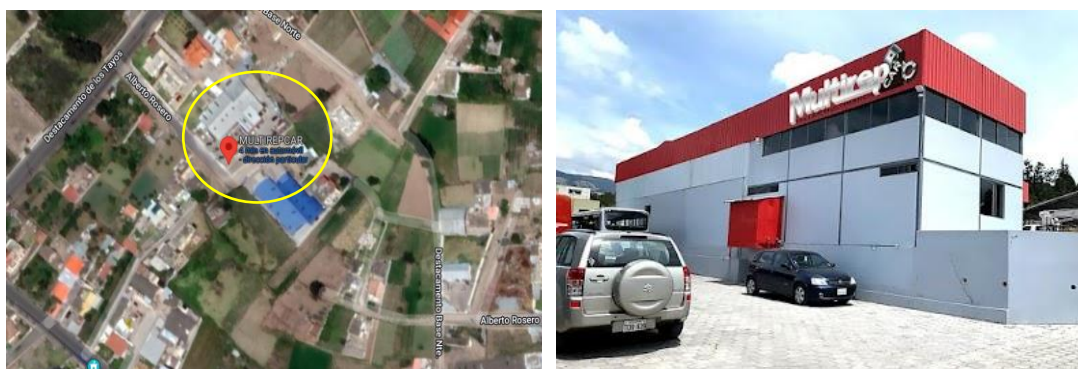
Figura 7. a) Ubicación de la empresa b) Instalaciones Multirepar
