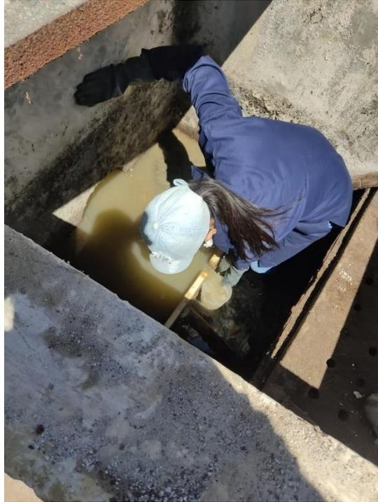
**Figura 45.** Medición del caudal de la PTAR.
