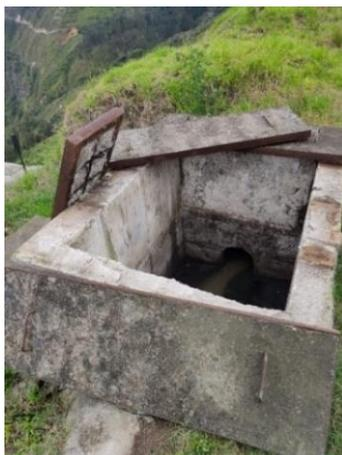
*Figura 7. Fisuras y deterioro en el tanque repartidor de caudal.*
