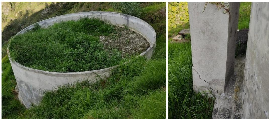
*Figura 18. Filtro anaerobio de flujo ascendente 1 de la PTAR.*
