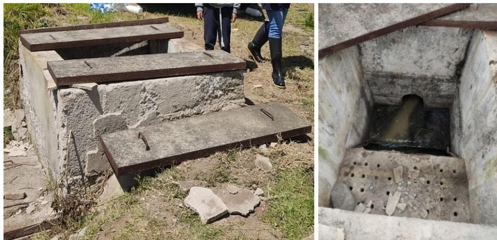
*Figura 16. Tanque repartidor de la PTAR.*
