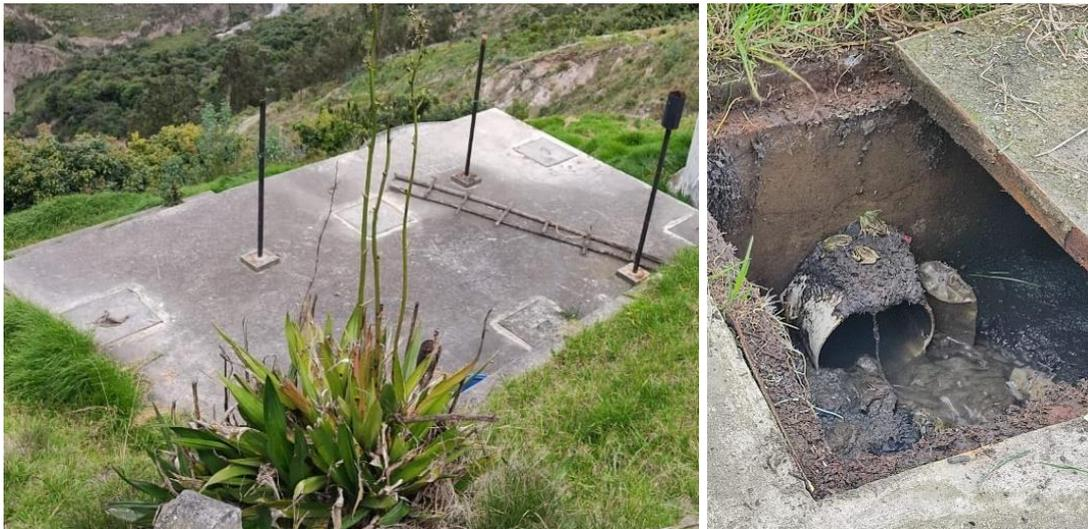
*Figura 17. Tanque séptico de la PTAR.*
