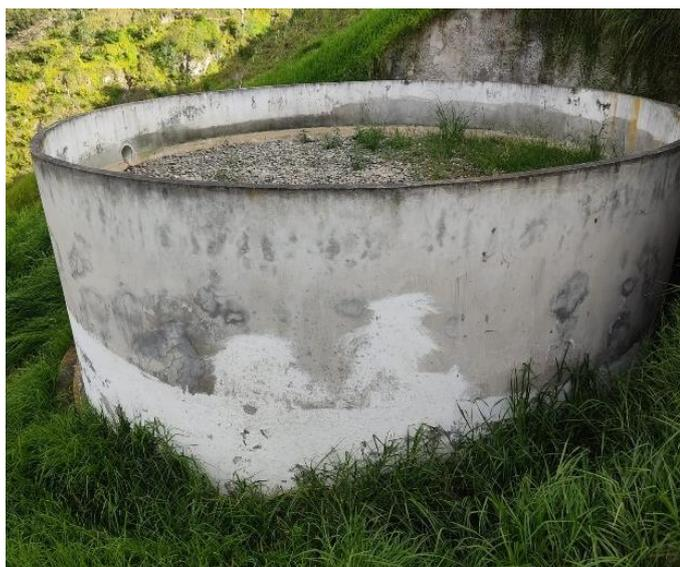
*Figura 19. Filtro anaerobio de filtro ascendente 2 de la PTAR.*
