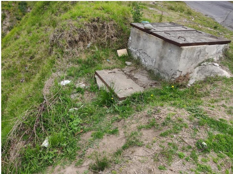
*Figura 50. Presencia de basura y materia vegetal alrededor del tanque repartidor de caudales por ausencia de cerramiento.*
