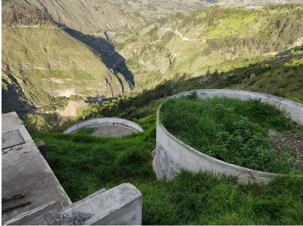
*Figura 49. Vista de filtros anaerobios de flujo ascendente.*
