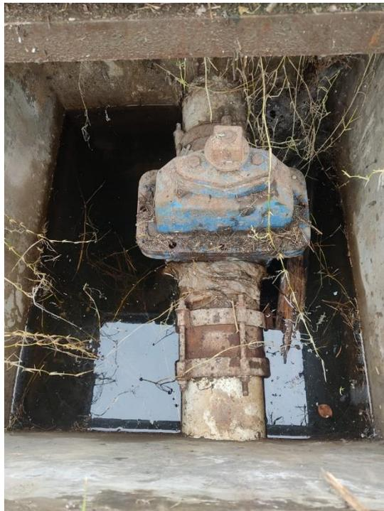
**Figura 48.** Estado actual de las válvulas de compuerta en la PTAR.
